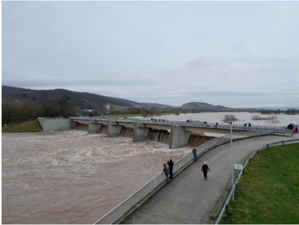
HWRB in Salzderhelden (Betreiber NLWKN) bei Vollstau mit ~43,7 Mio. m 3 Wasser, 27.12.2023 Foto: © NLWKN
